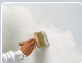
Aplicarea produsului Putzgrund cu ajutorul unei bidinele
