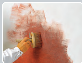
Aplicarea stratului de lazură (diluată cu cca. 15-20% apă)
