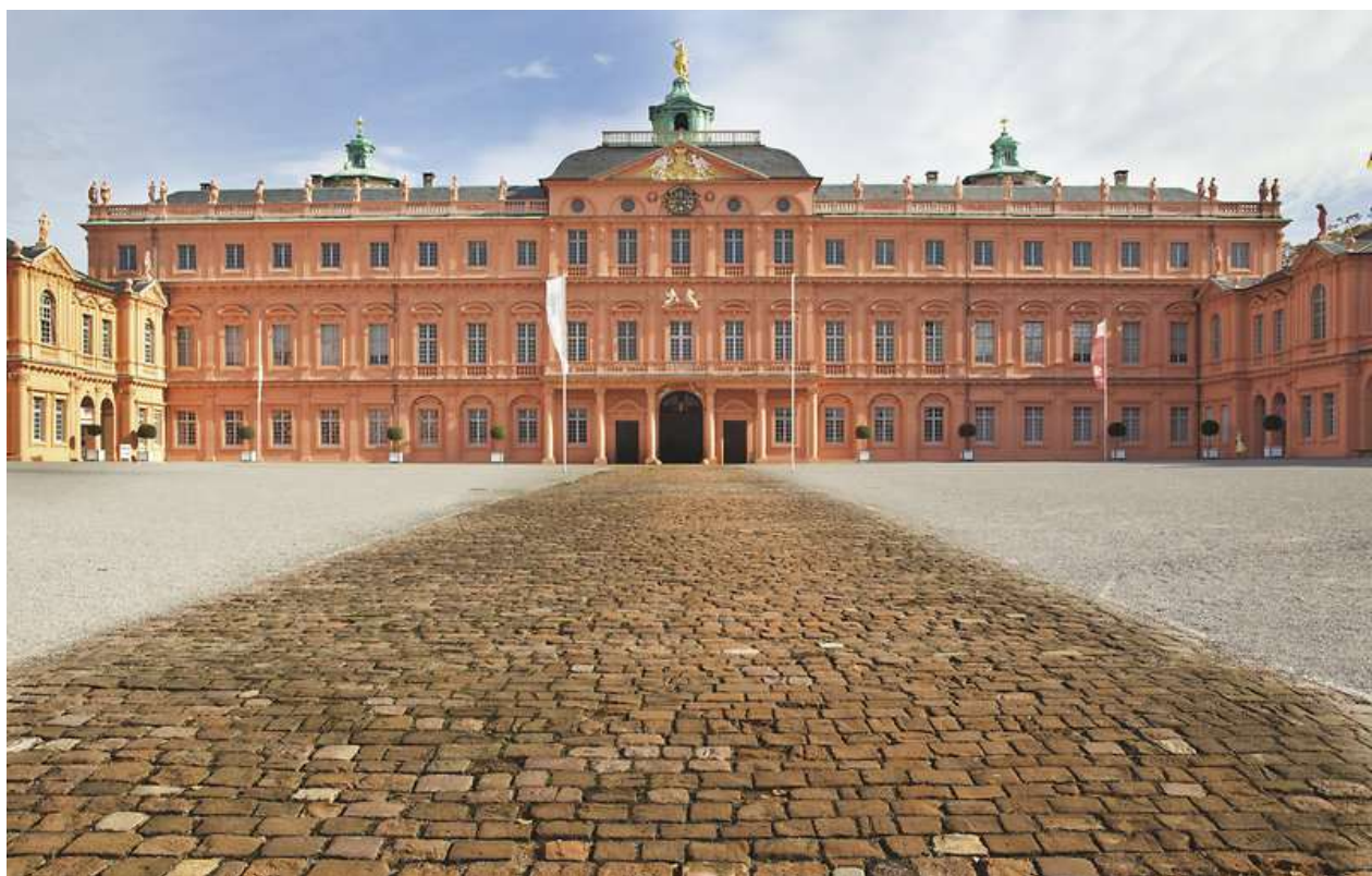
Castelul Rastatt, fațada restaurată în nuanțe baroc cu Histolith Kalkschlämme și Histolith Fassadenkalk
