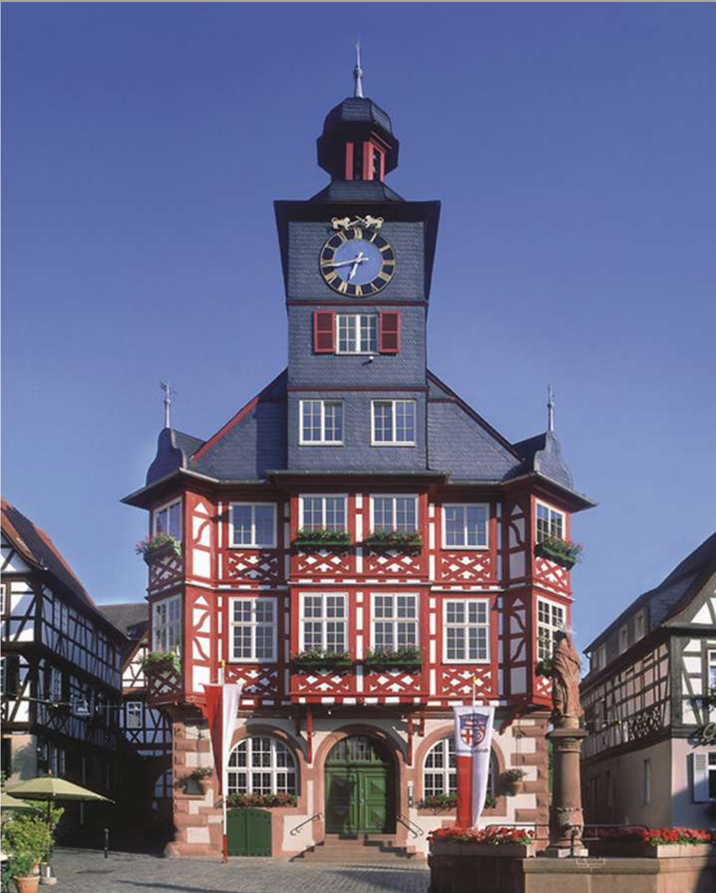
Primăria din Heppenheim, renovată cu Histolith Leinölfarbe
